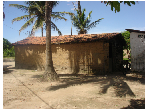
Lateral de casa de taipa.
